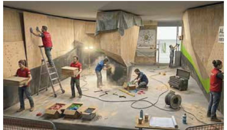
Die Boulderhalle in Lobming wird 2026 umfassend umgebaut
