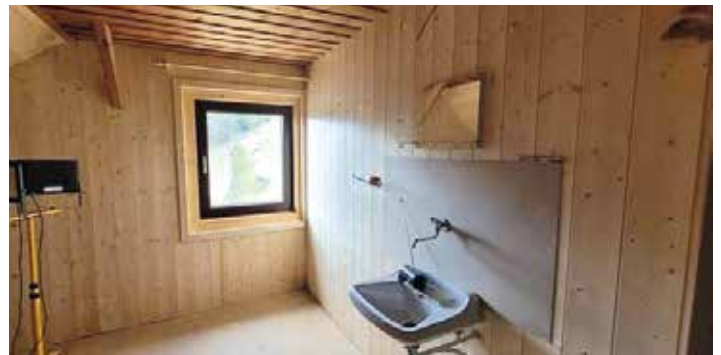
Das erste frisch renovierte Zimmer im Sattelhaus (Oskar-Schauer-Haus) auf der Terenbachalm (1.409 m)
